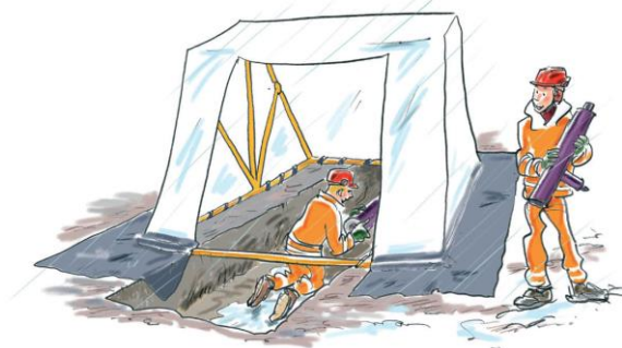
Traditionelle teltløsninger til kabel- og ledningsarbejde
